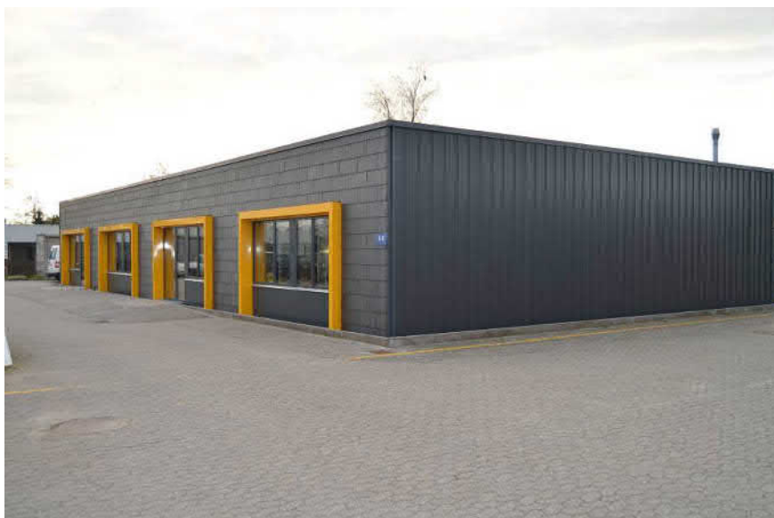
Figur 12: Nord- og østfacade efter renovering
