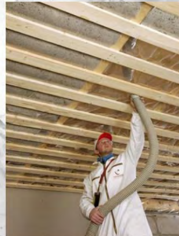
Монтаж в таван над конструкция Ваканционно селище "Топола скайс" до гр. Каварна
