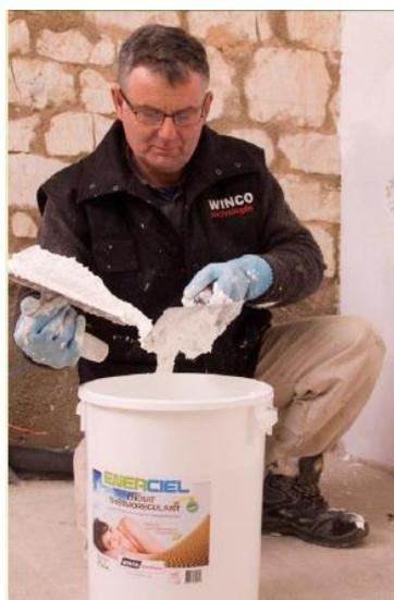
Figure 13 : Manual application of PCM render. Source : Enerciel
