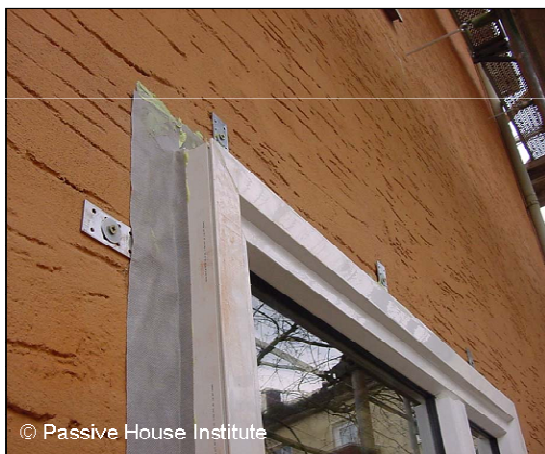
Tätning, utvändig gips
