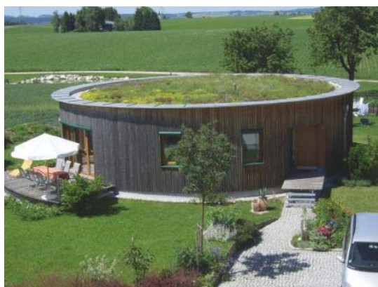
Passive House en Roitham, Austria, que abrirá sus puertas al público. Foto: Günter Lang
